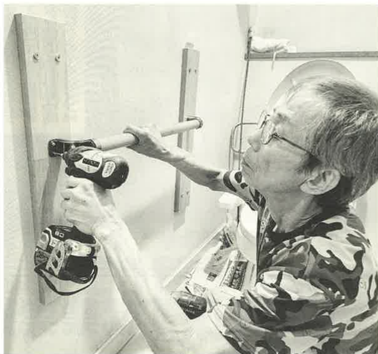
下地板で希望の高さに取り付け すみだ建築センターの深井さん
