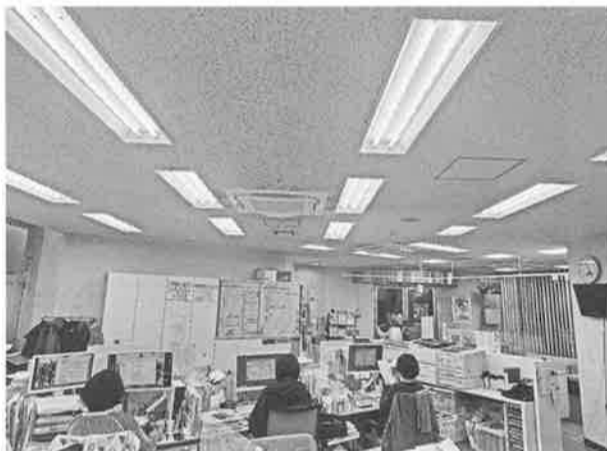
照明器具の更新工事を行ないます
